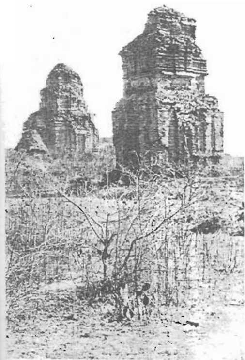
138. PHU HAI, North-Eastern view. PHÚ HÀI, nhìn từ phía đông bắc.
